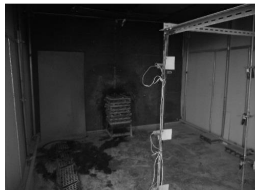
図 2 区画内の状況
