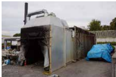
図3 当施設の外観
