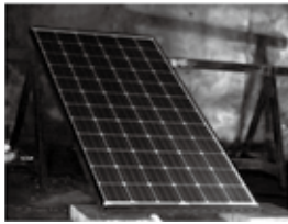
写真33 パネルの設置状況
