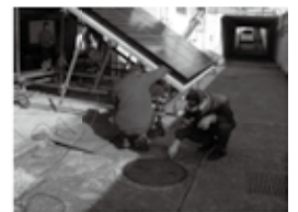
写真30 マンホール計測
