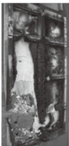
写真12 外装材取り外し 実験No. 15 横張り通気胴縁
