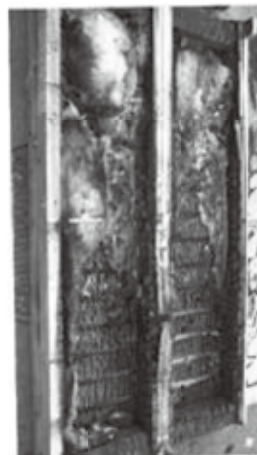
写真14 外装材取り外し 実験No. 17 内装モルタル仕上げ
