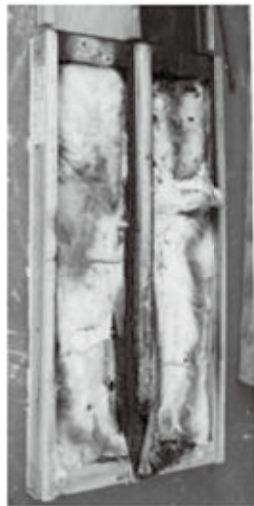
写真2 外装材取り外し 実験No. 1 基本設定
