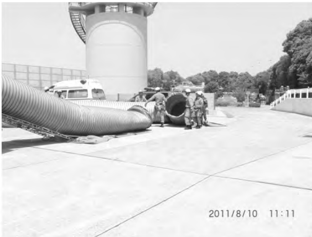
写真11 根本付近の送風管のはずれ
