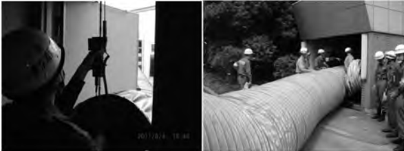
写真10 開口部付近と送風管
