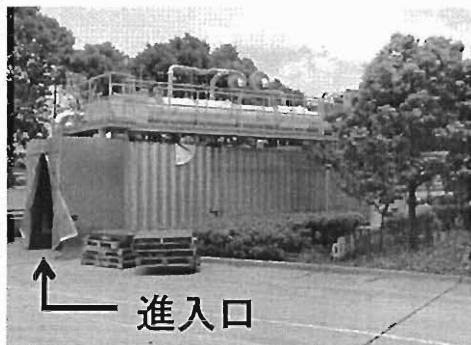
写真 1 コンテナ訓練施設進入口側
