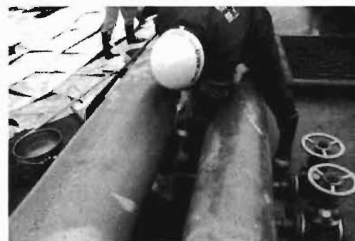
写真4 軽油漏えい現場からの気体試料採取
