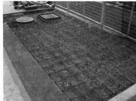
写真 1 5 異形棒鋼使用状況例
