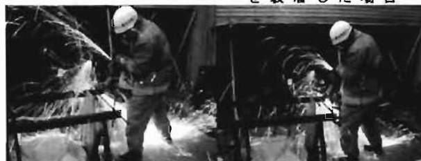
写真16 異形棒鋼の切断状況(エンジンカッター)
