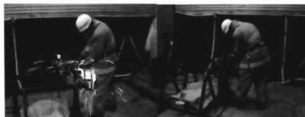
写真17 異形棒鋼の切断状況 (ディスクグラインダー)
