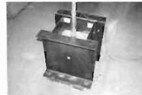
写真1 立て配管の固定状況
