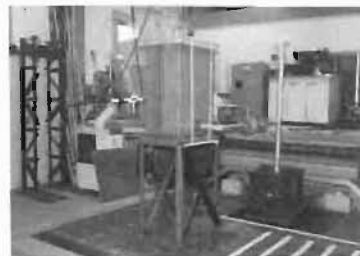
写真2 水槽と配管の状況
