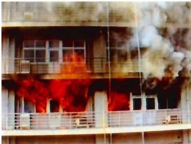
写真2-1 火災室の状況 (点火後3分)
