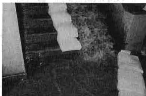
写真29 階段の排水状況
