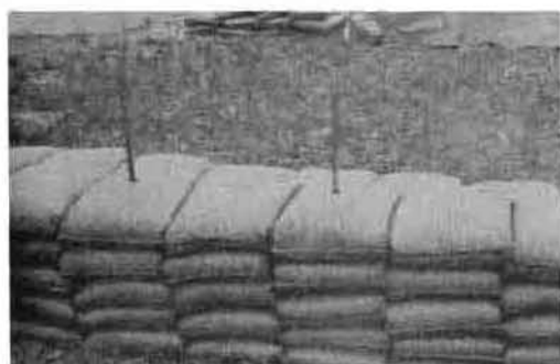
写真32 試験体Cにパイルを打込んだ状況
