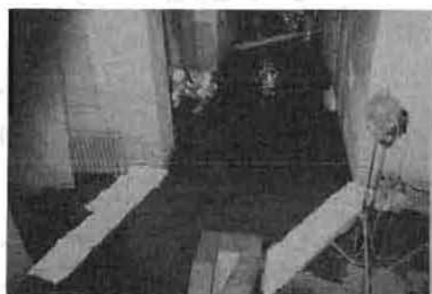
写真27 試験体D(左側)とCの漏水状況
