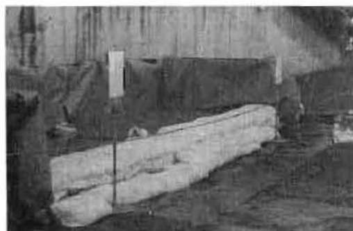
写真24 工法完成時の状況
