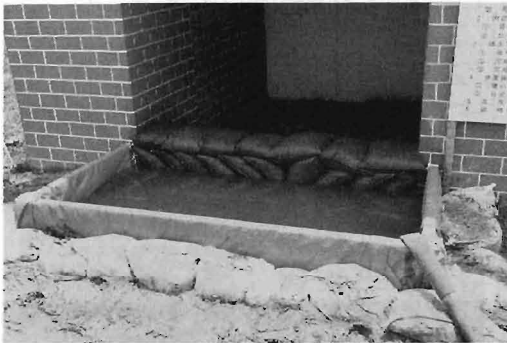
写真5 簡易止水工法実施状況
