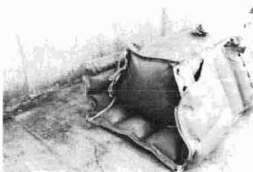
写真4 水のう連結部の状況
