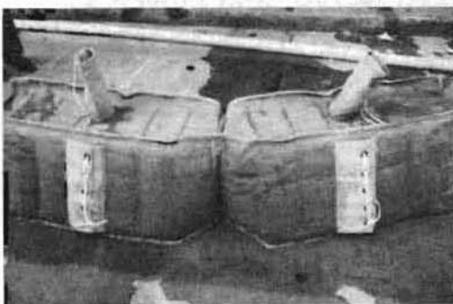
写真3 水のうに充水した状況
