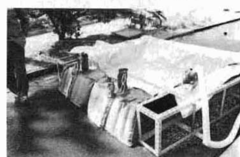
写真5 水のう一袋を展張した状況
