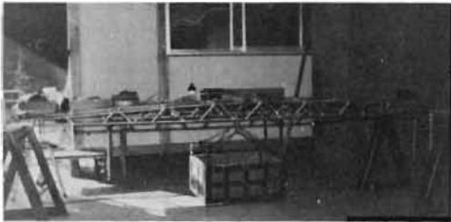
写真2 たわみ及びひずみの測定状況
