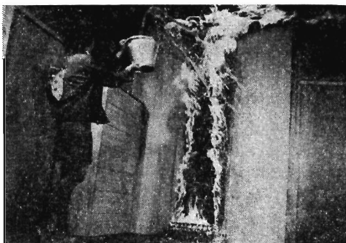
図8 改良型セバレート式消火バケツによる消火状況
