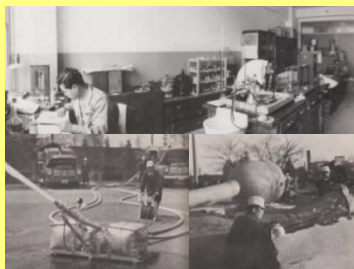
実験風景 化学実験室（上）、リモコン放水砲（左下）、高膨張性泡沫消火設備（右下）いずれも昭和36年～38年頃
