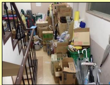
1回目の立入検査で 確認した違反の状況
