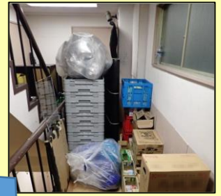
2回目の立入検査で 確認した違反の状況
