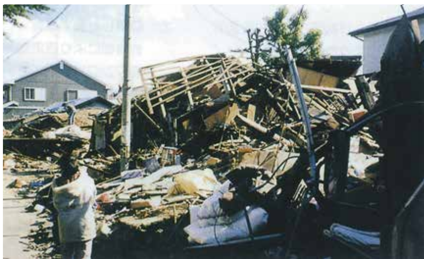
震災後の建物の状況
