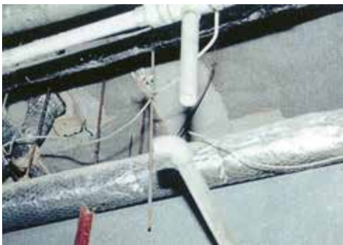
スプリンクラー設備の被害例
