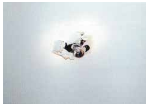
スプリンクラー設備の被害例
