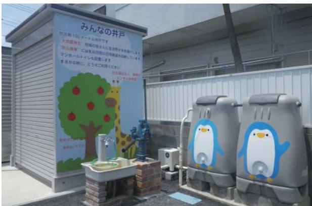
避難時の拠点として地域の皆さんへ防災井戸設置
