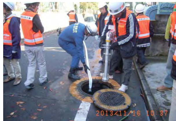
総合防災訓練 スタンドパイプ取扱訓練
