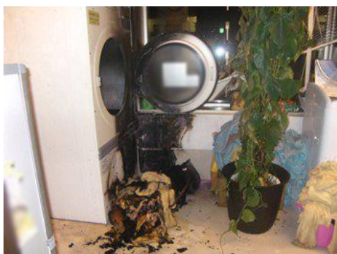
写真1-1 出火したリネン室の状況
