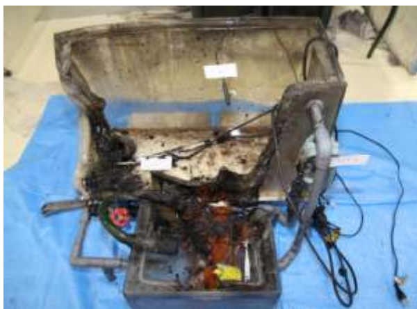
写真2-1 焼損した水槽
