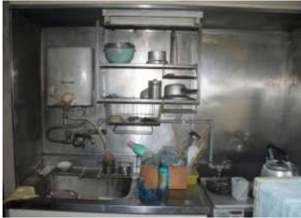
写真5 出火箇所の焼損状況
