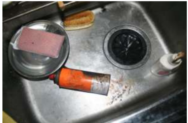
写真6 シンク内の焼損状況
