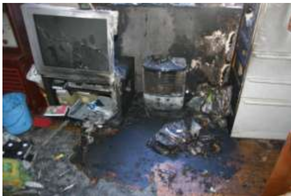
写真 2-1 出火箇所付近の状況
