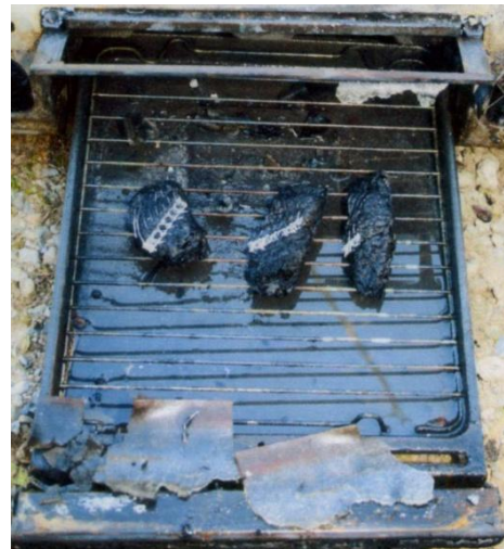
写真 2 グリル内の焼損状況
