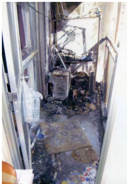
出火したベランダ～収容物は激しく燃えている
