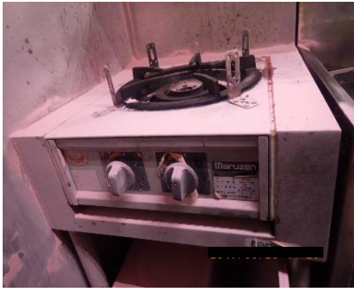
焼損したガスコンロの状況（写真のピンク色は消火剤の薬剤）
