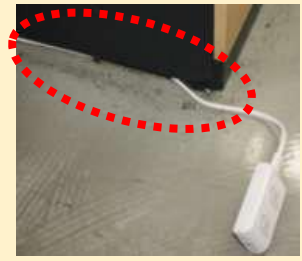
家具類の下敷き状態
