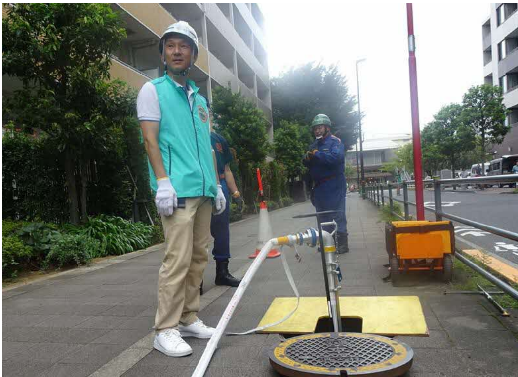
消防団員立ち合いの上、実際の消火栓からスタンドパイプを使用して送水中
