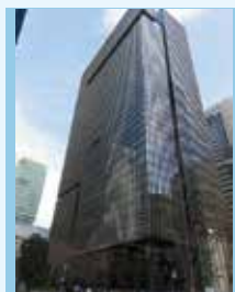
大手町タワー (地下4階、地下2階一部、 地下1階、1階、33階～38階) 初回認定日 H30.2.20
