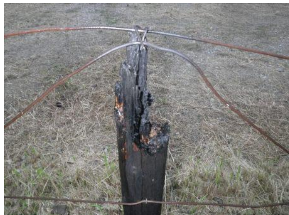
写真1-2 杭の焼損状況
