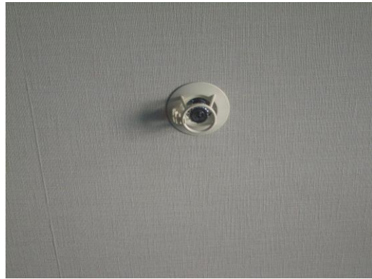
写真4 スプリンクラーヘッドの状況
