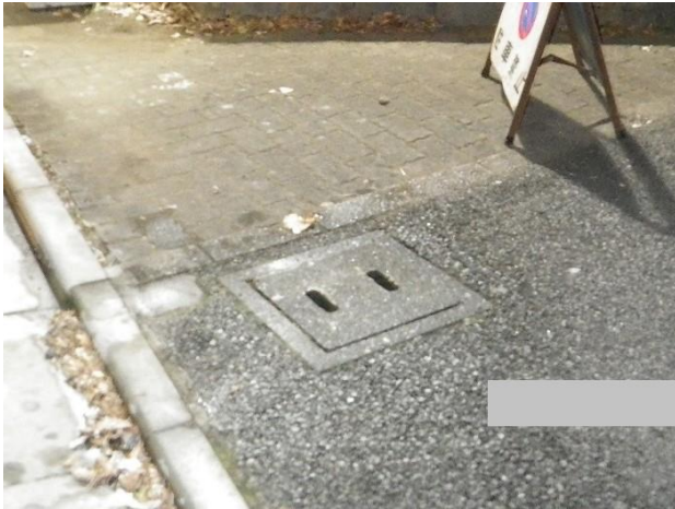
写真10 排水柵の状況
