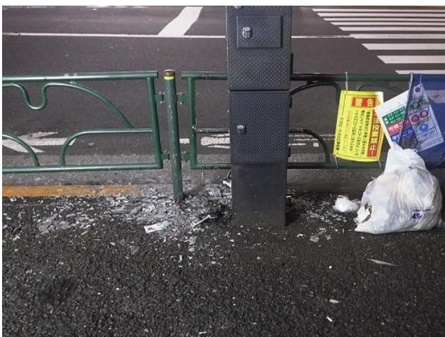
写真8 ごみ集積場の焼損状況
