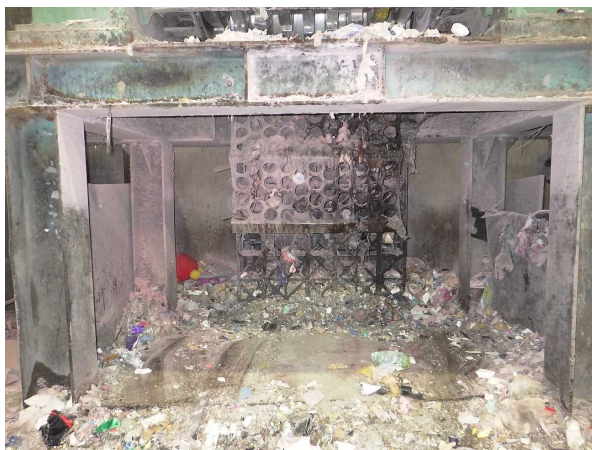
破砕機の下方向周の様子
