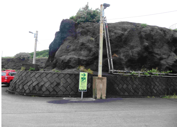
配管の敷設状況
