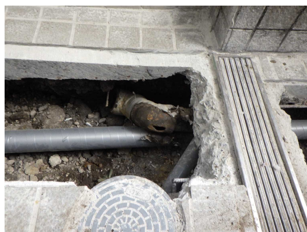
埋設配管の設置状況
