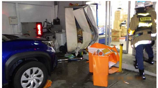
事務所出入口等の破損状況
