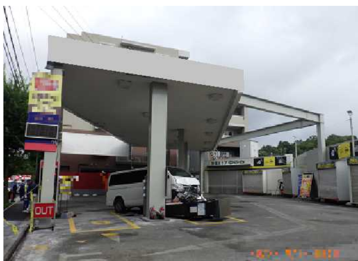
給油取扱所全体
