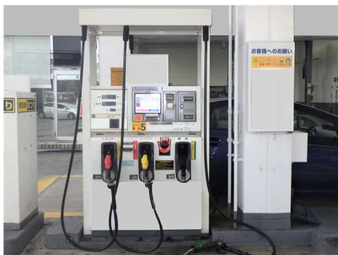
事故の発生した固定給油設備の状況 (軽油の給油ノズルが落下している。)
