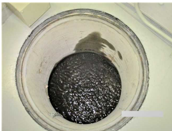
マンホールから地下ピットを撮影した様子 (灯油の油面が確認できる。)
