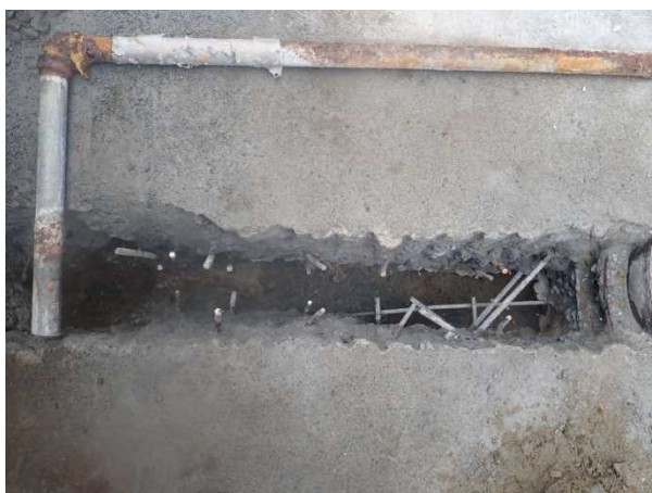
埋設配管を掘削した様子
