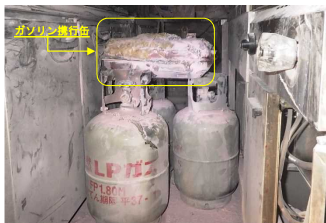
ガソリン携行缶の積載状況 (LPガスボンベの上に置かれ不安定な状態である。)
