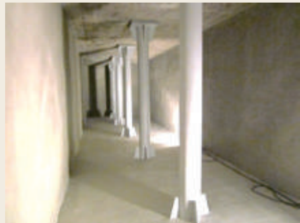
▲ 経年防火水槽の再生
