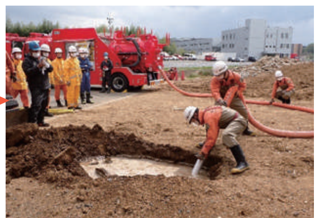
土砂吸引状況
