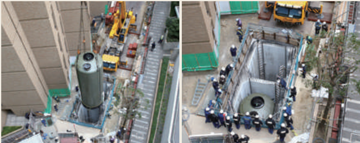
▲ 危険物タンクの設置時の状況
