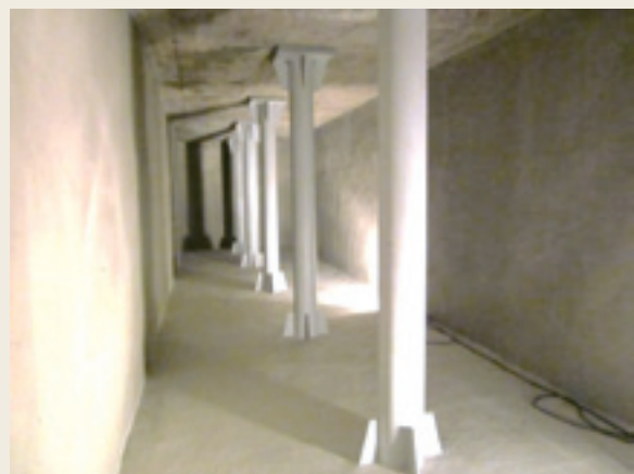
▲ 経年防火水槽の再生
