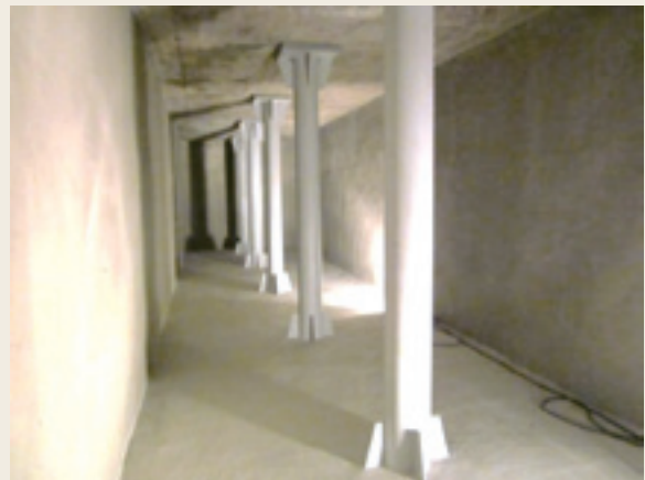
▲ 経年防火水槽の再生
