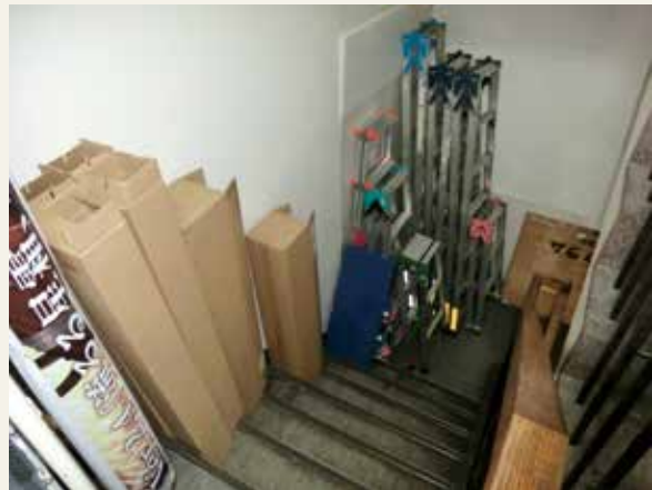
▲ 法令違反となる避難施設における物件存置の状況
