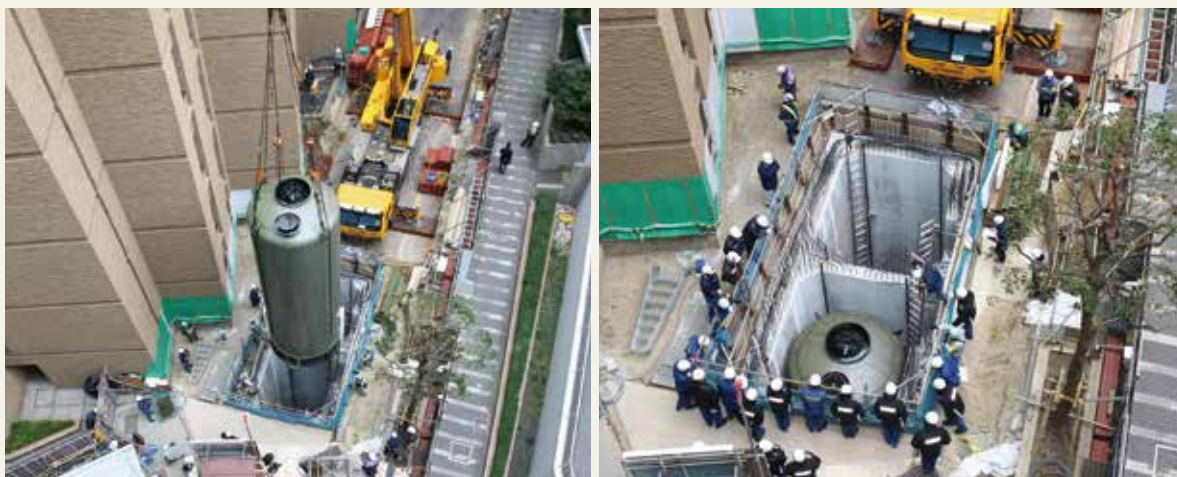
▲ 危険物タンクの設置時の状況
