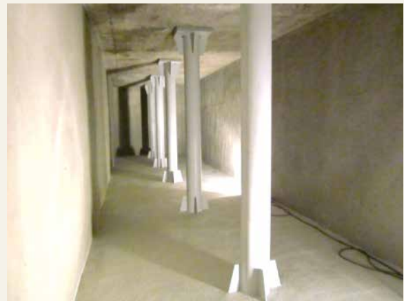
▲ 経年防火水槽の再生
