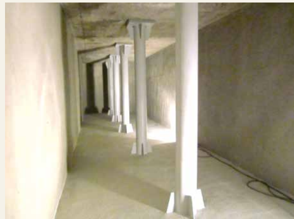
▲ 経年防火水槽の再生
