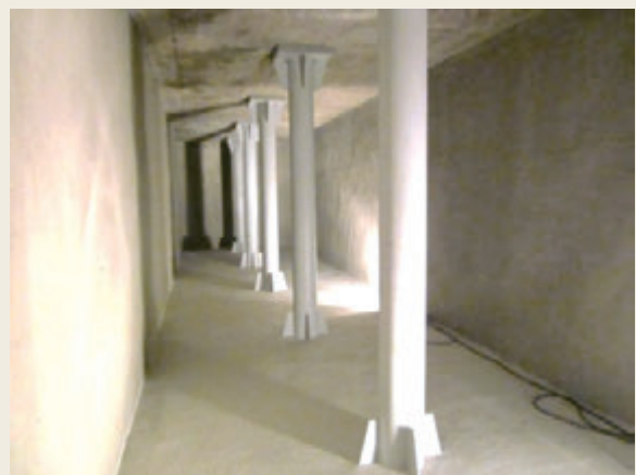
▲ 経年防火水槽の再生
