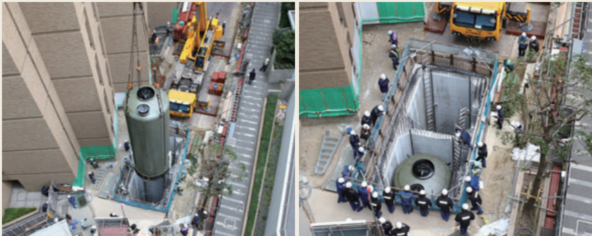
▲ 危険物タンクの設置時の状況
