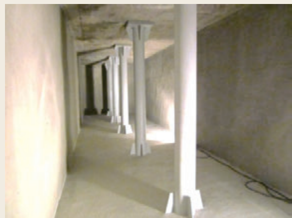
▲ 経年防火水槽の再生
