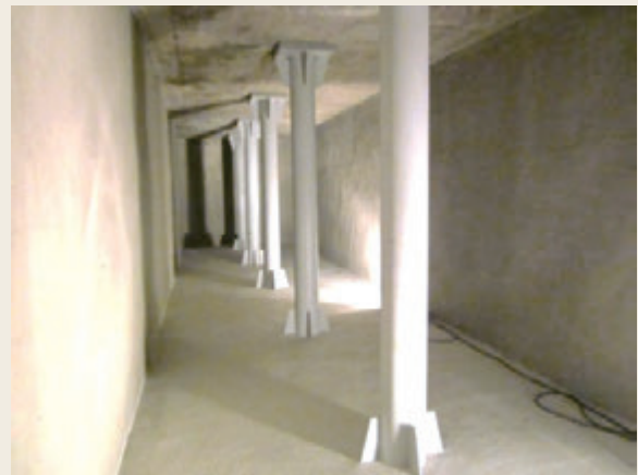
▲ 経年防火水槽の再生
