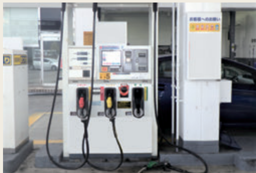
▲事故の発生した固定給油設備の状況（軽油のノズルが落下している）
