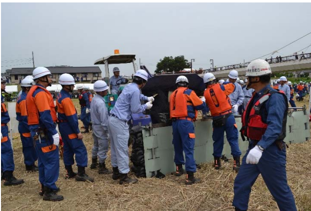
鋼板防護工法
