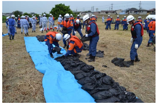
改良積み土のう工法
