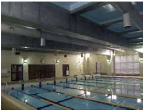
写真4 消防学校プール
