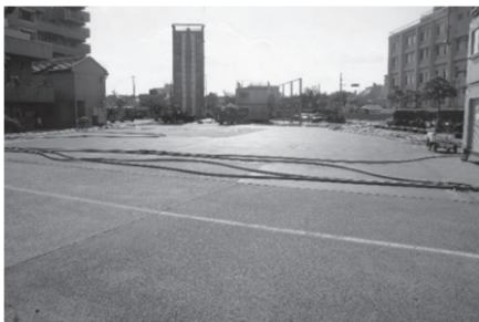
写真 10 ホース設定状況
