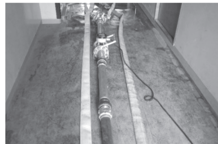
写真7 ホース設定状況 (流量計)
