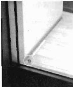
写真12 シール貼付位置例
